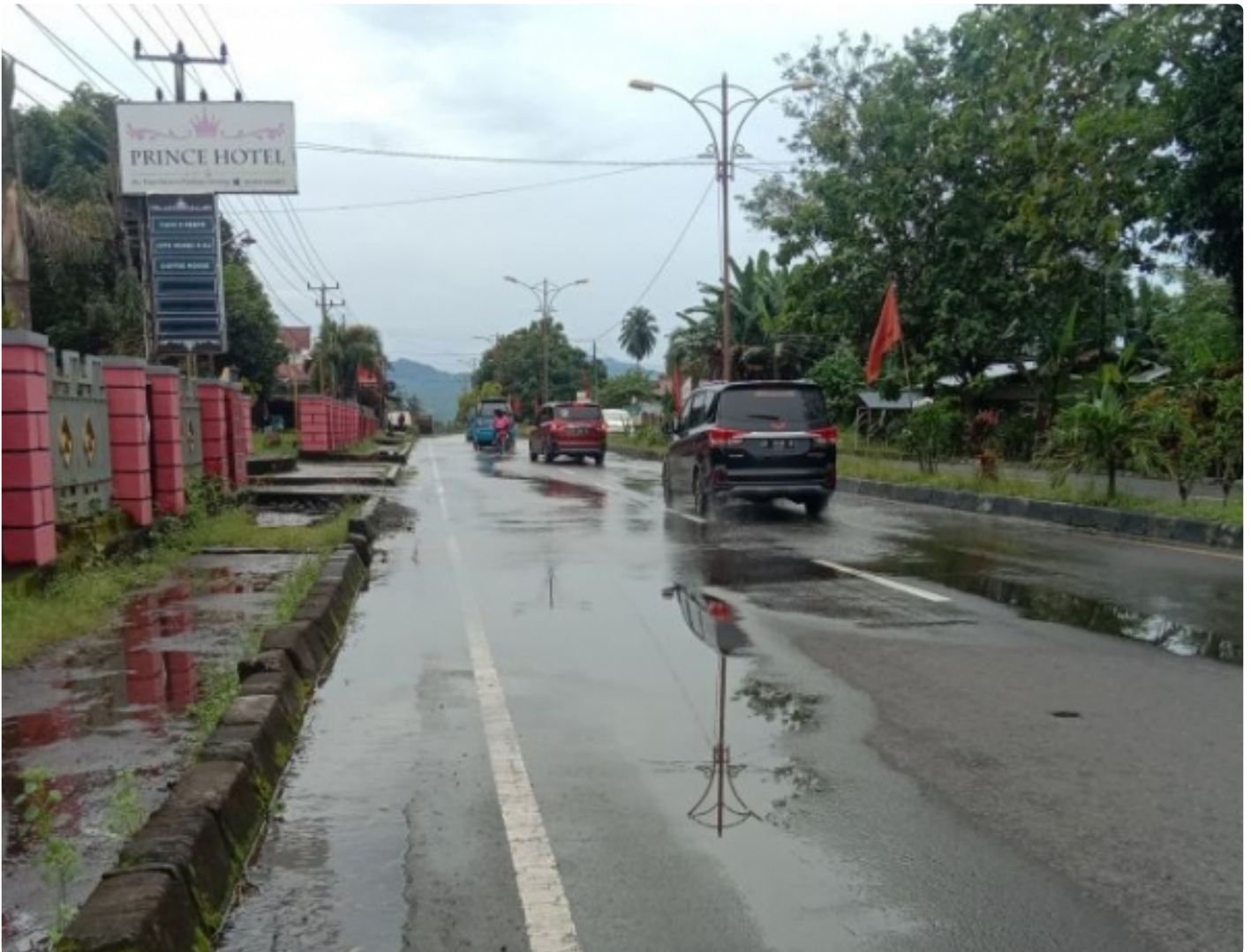
Jalan tergenang air
